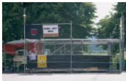
Die CSG hat den Brennkäfig fertig aufgebaut ... Foto: Mathias Münch
